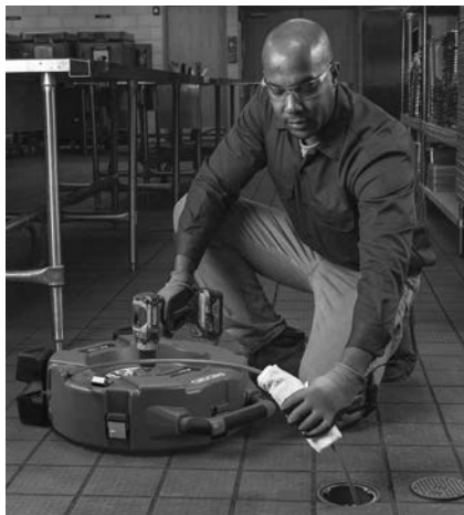
Figura 13 – Ungerea manșonului cablului
