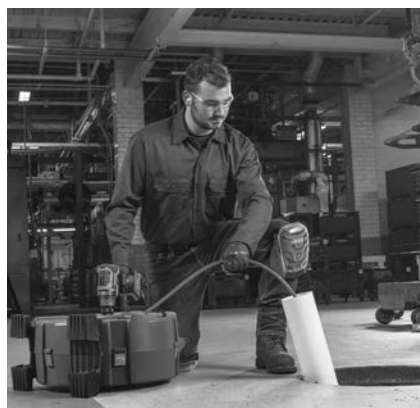
Εικόνα 5 – Παράδειγμα πρόετασης του ανοίγματος πρόσβασης στην αποχέτευση σε απόσταση εντός 3' από την έξοδο του σπιδάλ στο μηχάνημα
