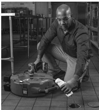
Figur 13 - Påføring av smøremiddel på kabelmantelen
