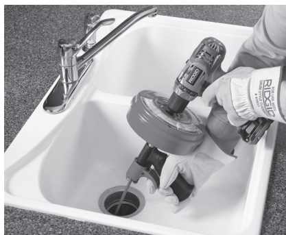
8A ábra – A Power-Spin használata akkumulátoros fúróval
