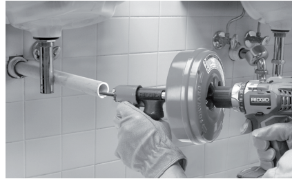
Şekil 7 - Kanal Açıklığının 4" (100 mm) Mesafesine Kanal Genişletme Örneği
