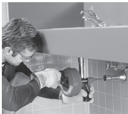
Abbildung 8 – Power-Spin manuell eingesetzt
