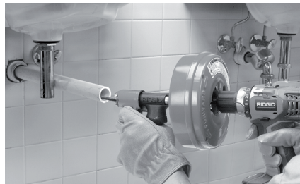
Figura 7 – Exemplu de prelungire a canalului la mai puțin de 4" (100 mm) de deschizătura canalului
