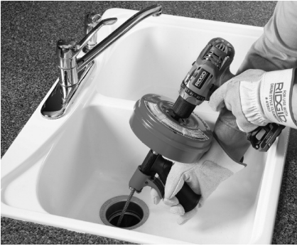
Figure 8A – Utilisation du Power-Spin monté sur perceuse à piles
