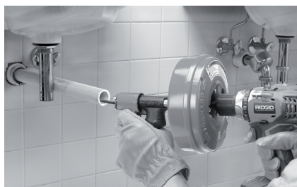
Εικόνα 7 – Παράδειγμα προέκτασης αγωγού αποχέτευσης μέχρι και 4" (1 μέτρο) το πολύ από το στόμιο του αγωγού αποχέτευσης
