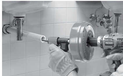
Figur 7 – Exempel på hur du kan förlänga avloppet till 4" (100 mm) från avloppets öppning
