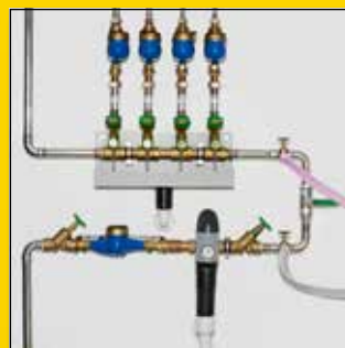
Płukanie instalacji wody pitnej (S/SL/SLW)
