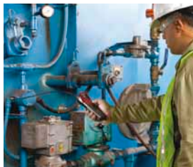
Urządzenia micro CD-100 można używać do wykrywania gazów podczas konserwacji zakładów i budynków
