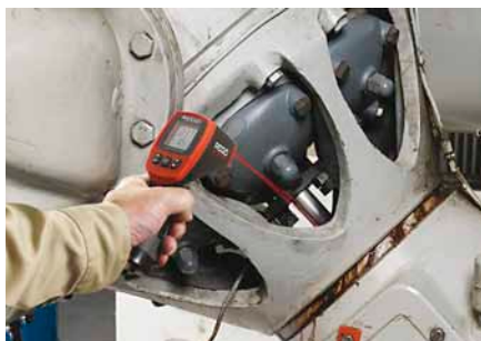
Pomiar temperatury zużywalnych części w ramach konserwacji prewencyjnej
